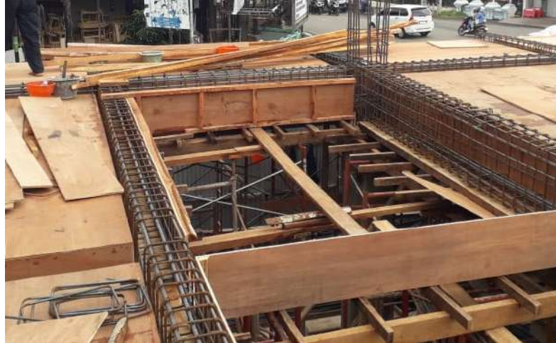
Gambar 5. 6 Pemasangan Beksiting Balok
