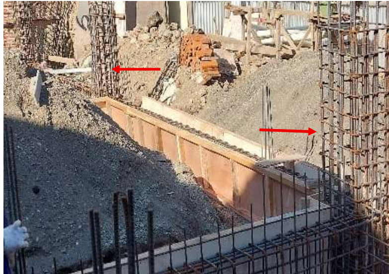
Gambar 5. 1 Pekerjaan Penulangan Kolom
