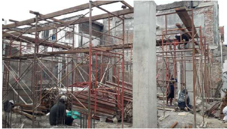
Foto pekerjaan perancah bekisting balok
