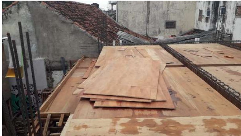
Gambar 5. 9 Proses Pemasangan Beksiting Pelat Lantai
