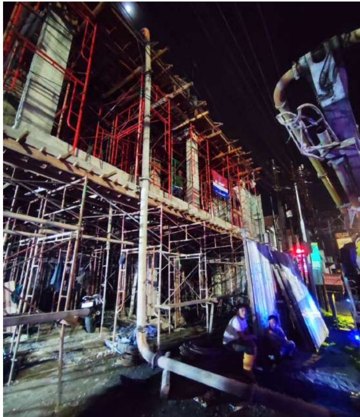
Gambar 5. 12 Proses pengecoran balok dan pelat
