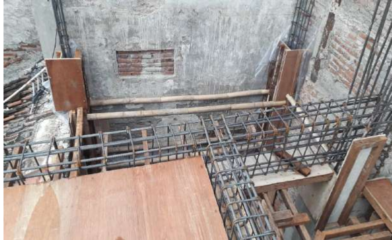
Gambar 5. 7 Pekerjaan Pemasangan Tulangan Balok
