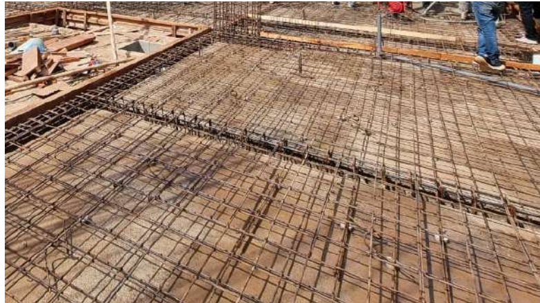
Gambar 5. 10 Proses Penulangan Pelat Lantai
