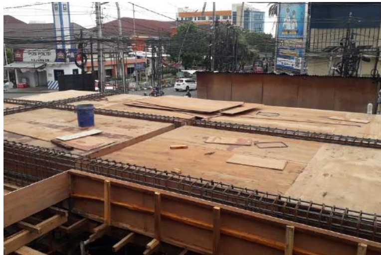
Foto Pekerjaan Dilapangan
