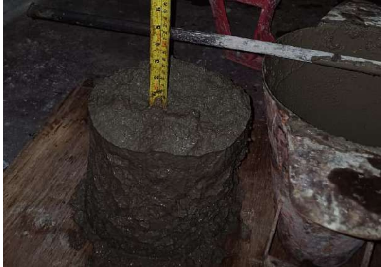
Gambar 5. 11 Test Slump Balok dan Pelat Lantai
