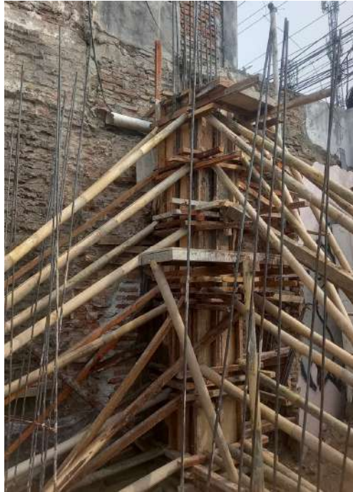
Gambar 5. 2 Pekerjaan Pemasangan Bekisting
