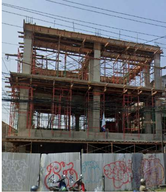
Foto pekerjaan balok dan pelat
