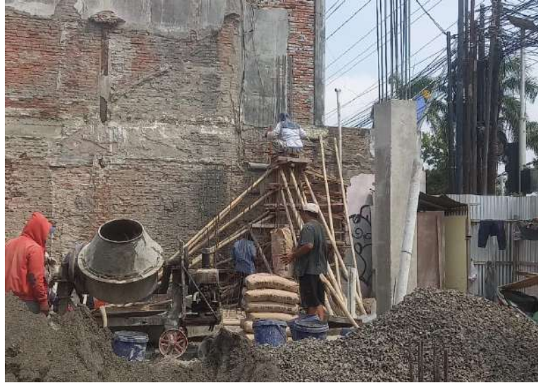
Gambar 5. 4 Proses pengecoran kolom
