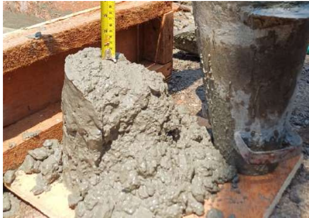
Gambar 5. 3 Tes Slump Kolom
