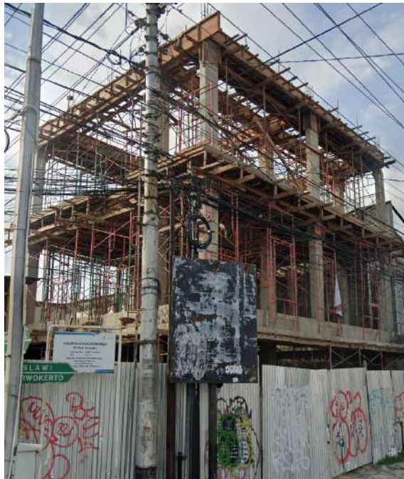
Foto pekerjaan balok dan pelat
