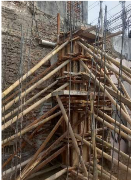
Foto pekerjaan beksiting pada kolom
