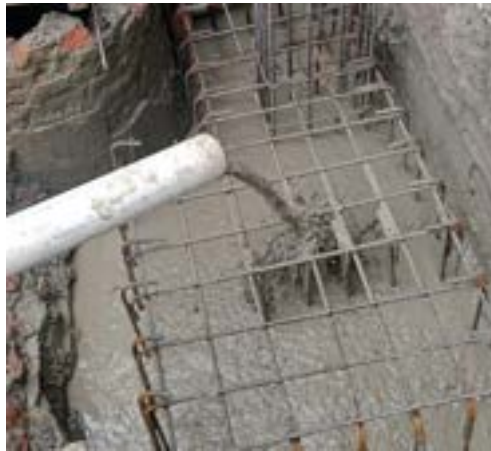
Gambar 4.16 Pekerjaan Pile Cap
