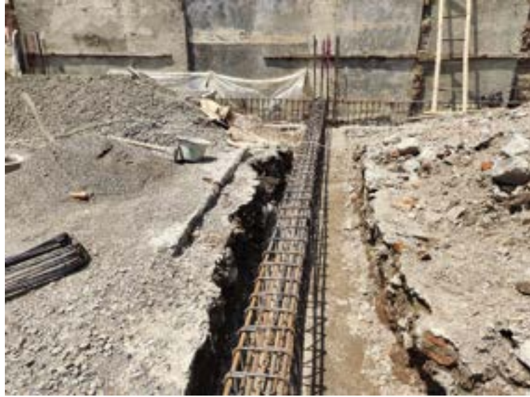
Foto Tulangan Tie Beam
