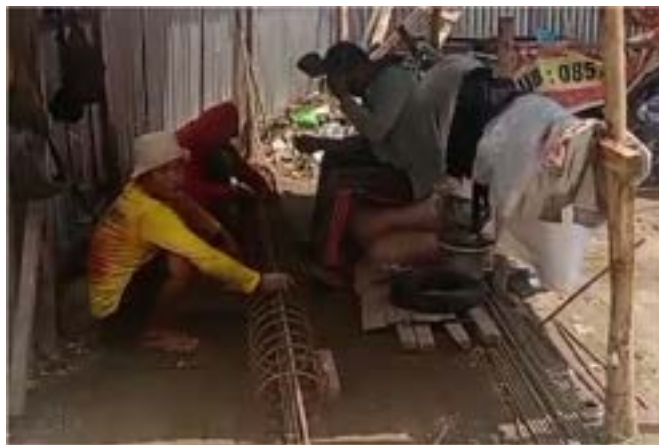
Foto Pabrikasi Untuk Pondasi Bore Pile
