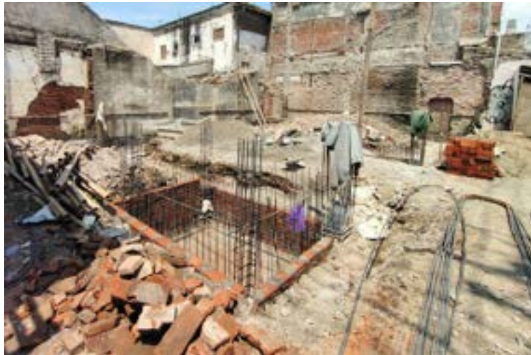
Foto Pekerjaan Dilapangan
