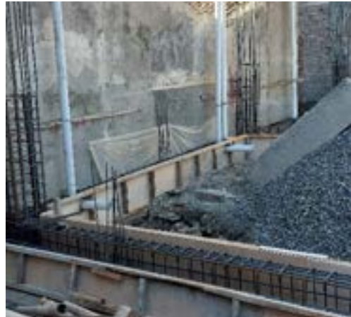
Gambar 4.17 Pekerjaan Tie Beam
