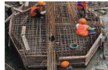
06 PEMBESIAN PILE CAP
