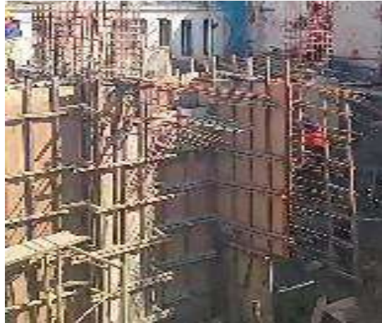
Gambar 4.21 Pekerjaan Kolom Pada Dinding Beton
