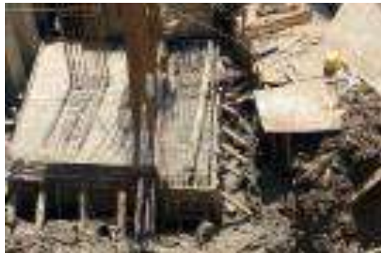
Gambar 4.17 Pekerjaan PileCap
