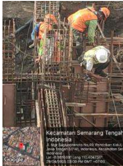
Gambar 4.28 Pekerjaan Tie Beam
