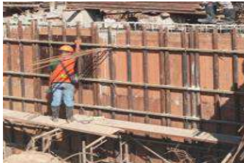
Gambar 4.24 Pekerjaan Dinding Beton
