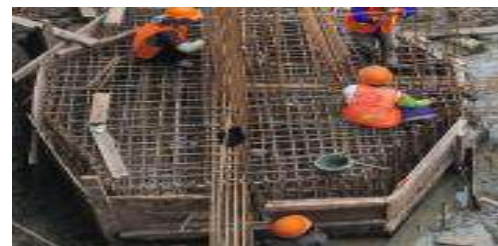
07 PEMASANGAN BEKISTING
